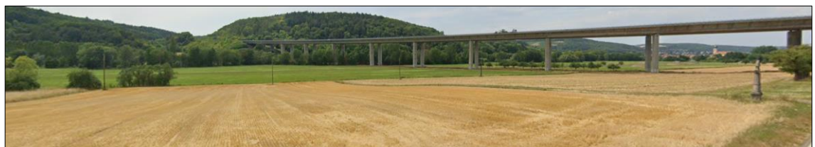
Abbildung 7: Blick Distelhausen Richtung A81
